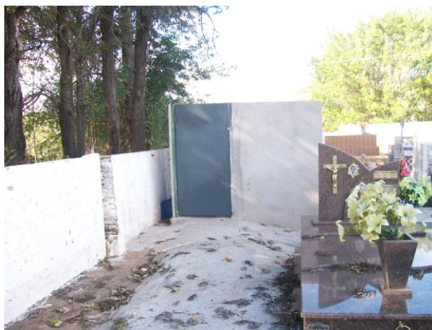
Figura 18 - Construção de área de descontaminação e descarte dos resíduos funerários.
