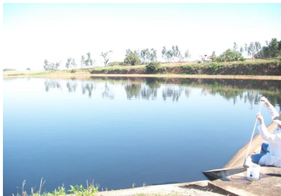
Figura 11 - Estação de Tratamento de Esgoto de Itajobi Fonte: Departamento Municipal do Meio Ambiente de Itajobi
